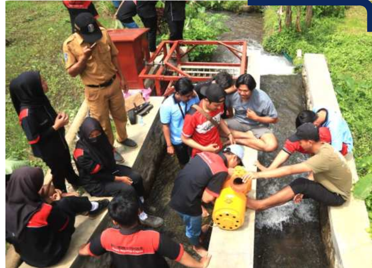
● Proses pemasangan kincir air di salah satu aliran sungai
