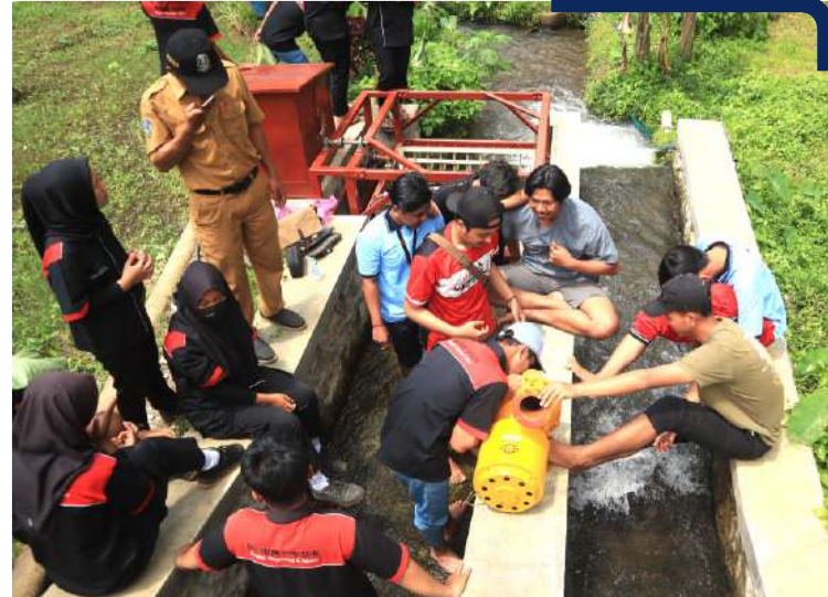
● Montageprozess der Wasserturbine an einem Flusslauf
